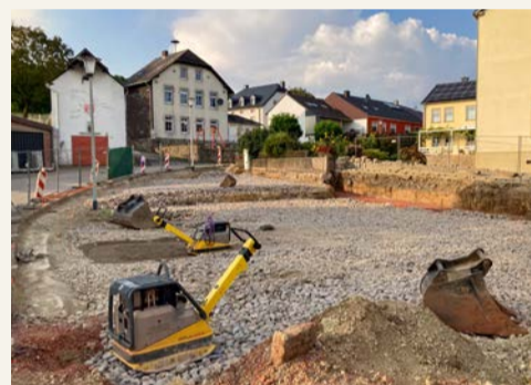
Baumaßnahme/ Tiefbau im September
