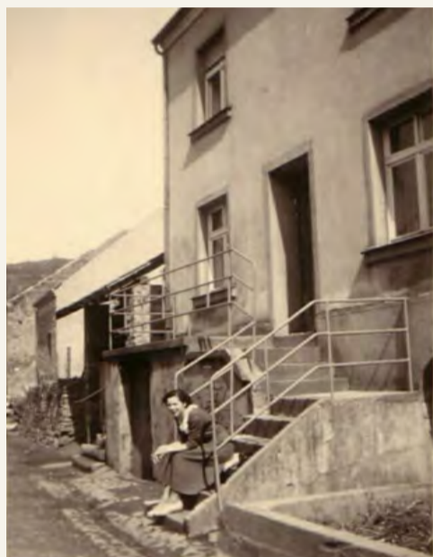
Gepflasterter Kulang (Ablaufrinne) bei Schank Träppchen, vor etwa 60 Jahren
